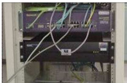
図 12: DVB-RCS モデム (中央にある約 2U の黒色の機器)
